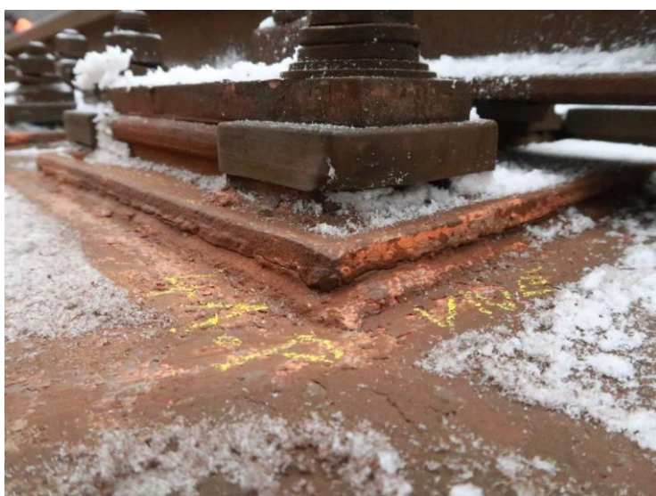
Foto č. 3 Přímé upevnění kolejnice, vpravo č. 41 vně - trhliny
