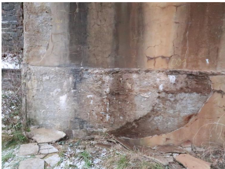
Foto č. 1 Opěra O 01 vpravo dole – opadaná omítka, degradovaný beton s výluhy pojiva.
