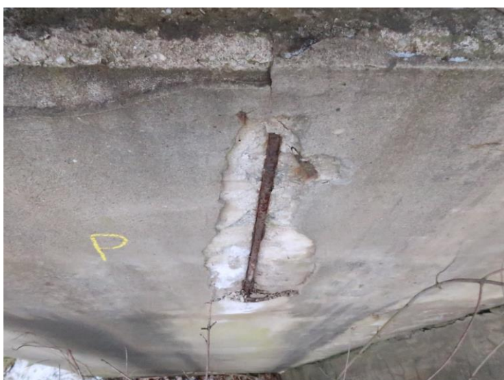
Foto č. 2 Opěra O 02 úložný práh zprava – degradovaný beton, obnažená korodující výztuž
